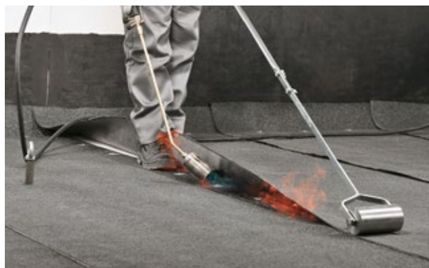
Рис. 3.46. Сварка шва с использованием газовой горелки
