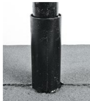
Рис. 3.33. Примыкание кровли к трубе
