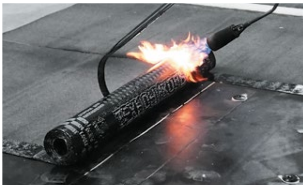
Рис. К.1. Наплавление по теплоизоляционным плитам
