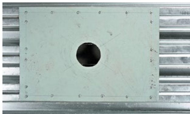
Рис. 3.4. Лист усиления в месте прохода через профилированный лист водоприемной воронки
