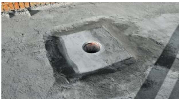
Рис. 3.12. Локальное понижение в месте установки воронки
