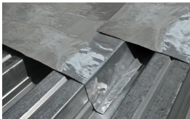
Рис. 3.6. Формирование продольного нахлеста пароизоляции на профлисте
