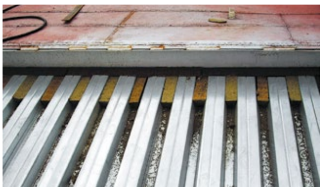
Рис. 3.1. Заполнение пустот ребер профнастила минераловатным утеплителем в местах примыкания.
