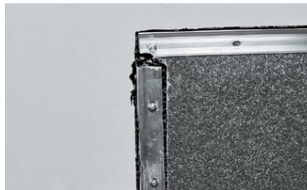
Рис. 3.23. Обрамление края кровельного ковра краевой рейки
