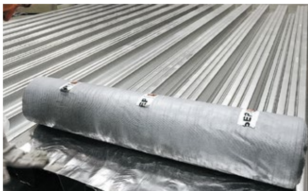
Рис. 3.5. Укладка пароизоляционного материала по профлисту
