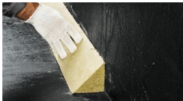
Рис. 3.13. Устройство наклонного бортика
