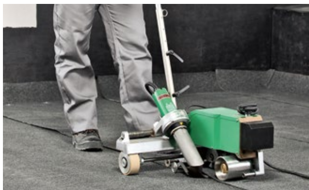
Рис. 3.45. Сварка шва автоматическим оборудованием
