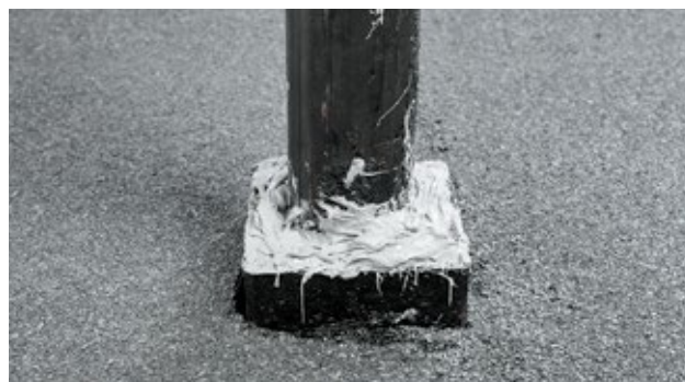
Рис. 3.37. Примыкание кровли к трубам малого диаметра
