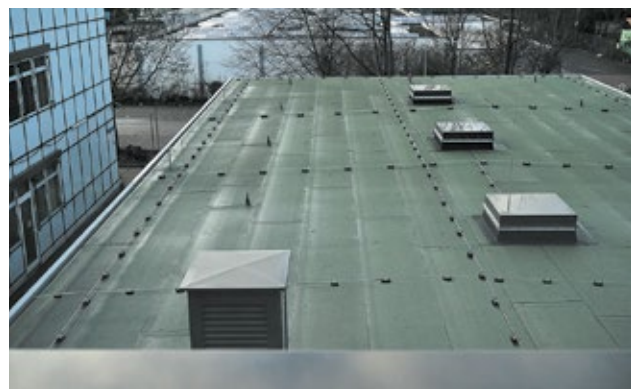
Рис. 3.55. Устройство молниеприемной сетки на кровле
