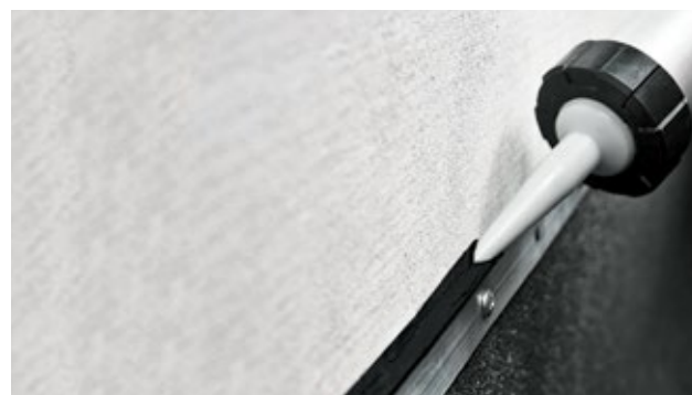
Рис. 3.24. Герметизация края краевой рейки
